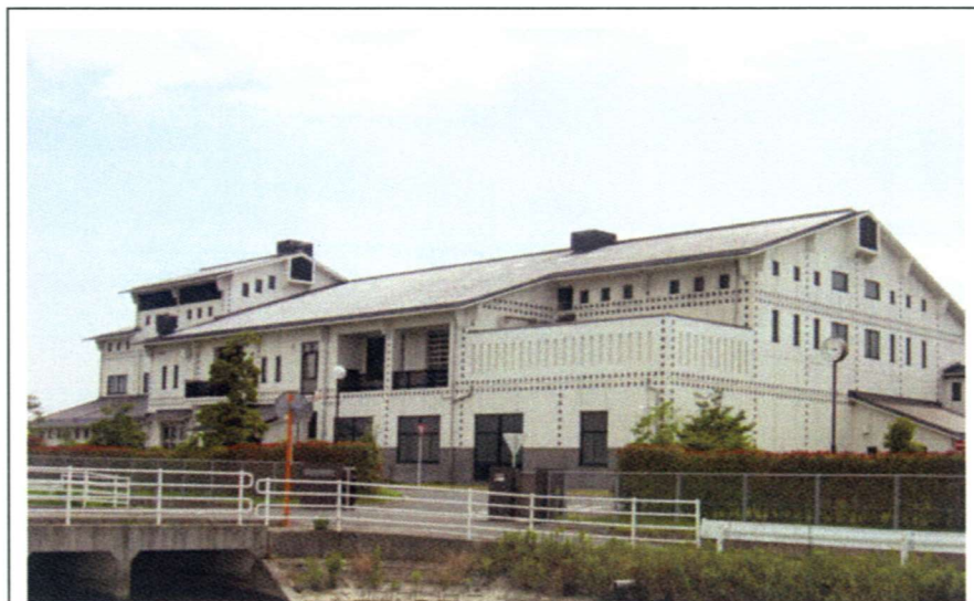
図 1. 5 三神地区汚泥再生処理センター
