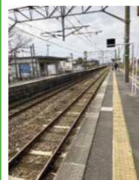
バリアフリー化が進んでいないJR中原駅
