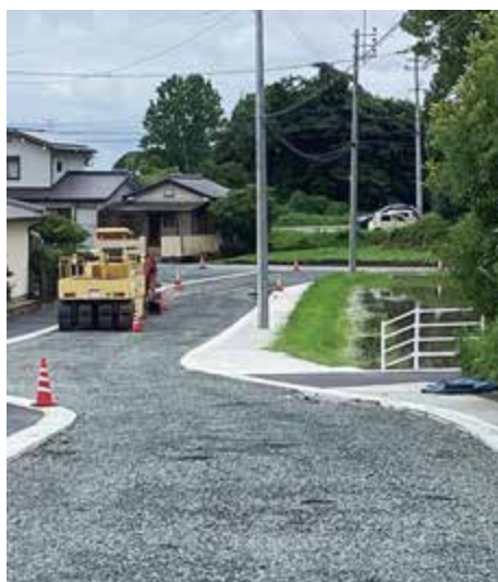
道路拡幅工事
