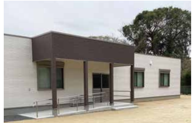
ボランティアセンター敷地内に増設
