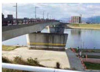
豆津橋の下部工部分
