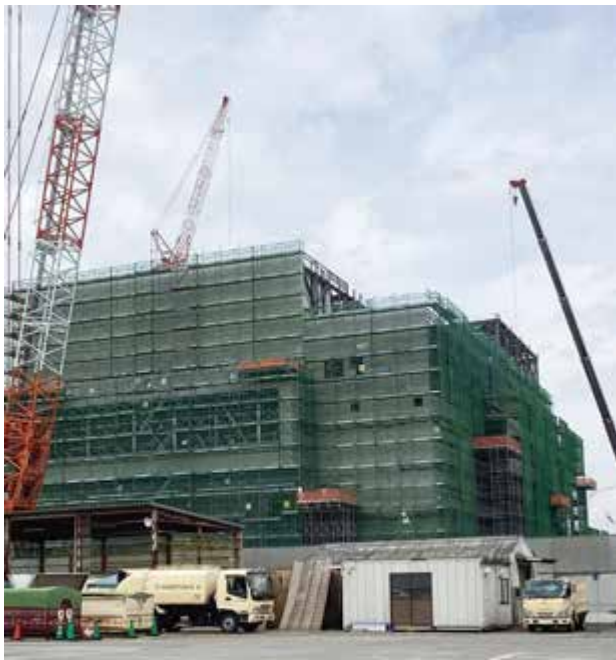
鳥栖市内に建設中の新しいごみ処理施設
