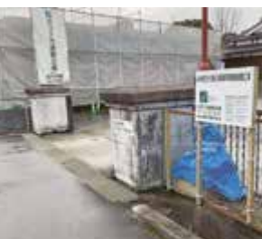
改修中のボランティアセンター
