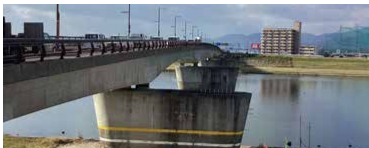
4車線化できるようになっている豆津橋下部工
