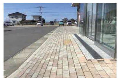
みやき町防災センター南玄関
