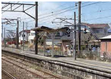
中原駅ホームの屋根
