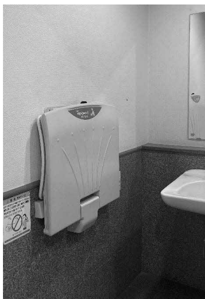
多目的トイレのおむつ交換台
