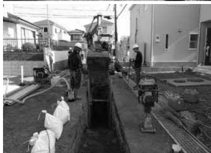
下水道工事の様子
