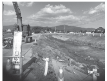
整備改良工事中の幹線水路(中津隈東・西区)
