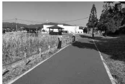
整備された東側の遊歩道
