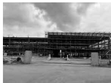
建設中のメディカルコミュニティセンター
