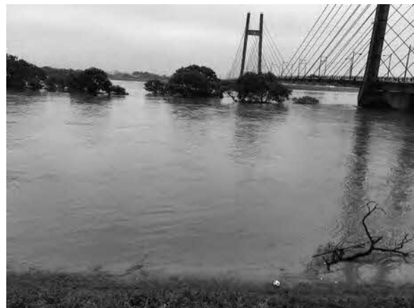
増水した筑後川
