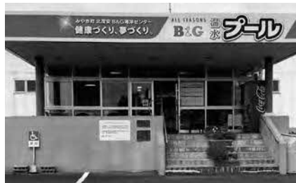
令和3年4月リニューアルオープンを目指し、いよいよ改修工事が始まるB&G海洋センター
