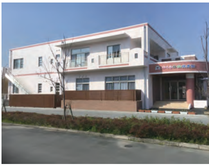
さくらの村保育園増築棟
