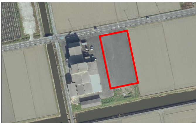
白壁ライスセンター 大字白壁7518
