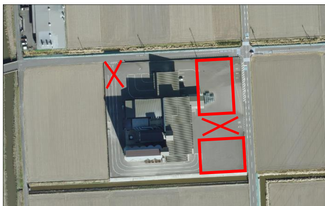
三養基共乾 大字市武79-3
