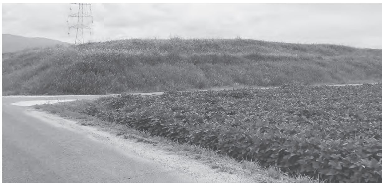
盛り土の状況
