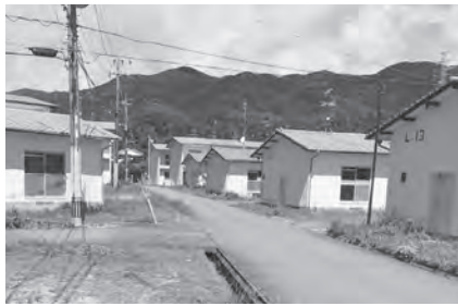
今年度解体される綾部団地
